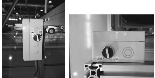
図5 自動・手動切替及び上昇・下降スイッチ
